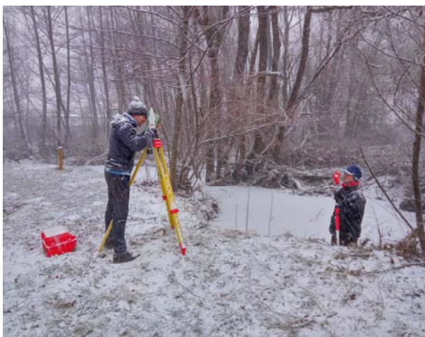
Slika 1: Geodetske meritve profilov reke Sotle v februarju 2017. Foto: Regina Kolenc.
