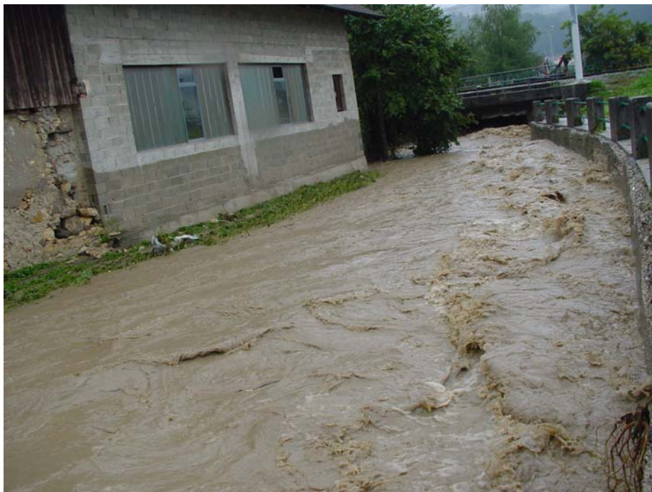
Slika 13. Na gradbenem objektu vidna sled najvišje vode Sevnične v Sevnici dne 21. avgusta 2005 ob 12:38 (foto: Jože Uhan).
